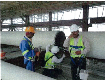
管内の状況をモニターで確認
